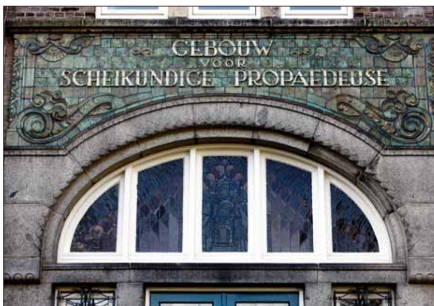
'Gebouw voor Scheikundige Propaedeuse' valt er nog te lezen op de voormalige entree aan de achterzijde van het studentencomplex. De oude bebouwing aan het De Vries van Heijstplantsoen stamt uit 1923 en deed dienst als Laboratorium voor Algemene en Analytische Chemie voor wat toen nog de Technische Hogeschool heette.
