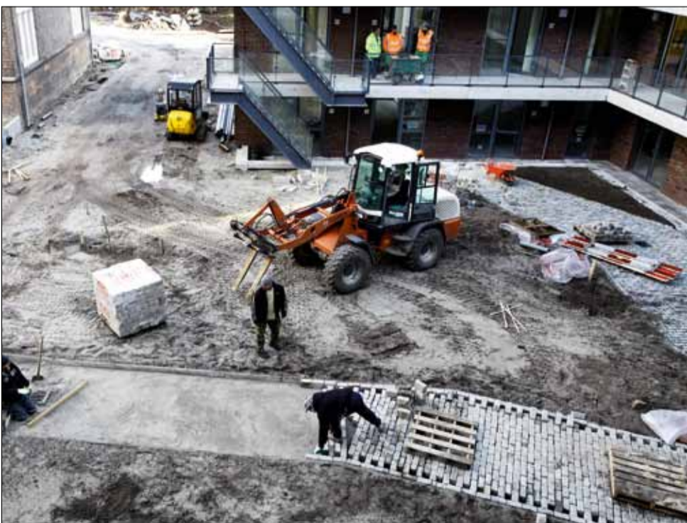
Naast het terras komt een gemeenschappelijke tuin. Buiten werken stratenmakers hard aan kronkelpaadjes tussen het nog te planten groen.
